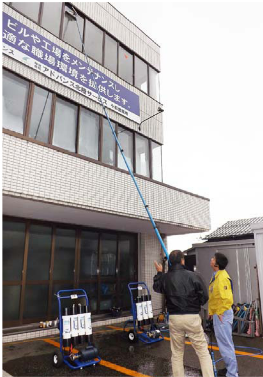
アクアクリンシステムを使った清掃作業。簡単に3階のガラスをふき取れる
